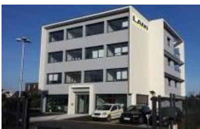
Réalisation du siège de l'entreprise LANG à Saint Nazaire. 1 200 000 € en TCE
