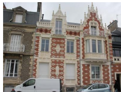
Restauration de l'ancien Hôtel Wilson situé en front de mer à Saint-Nazaire 350 000 € en GO
